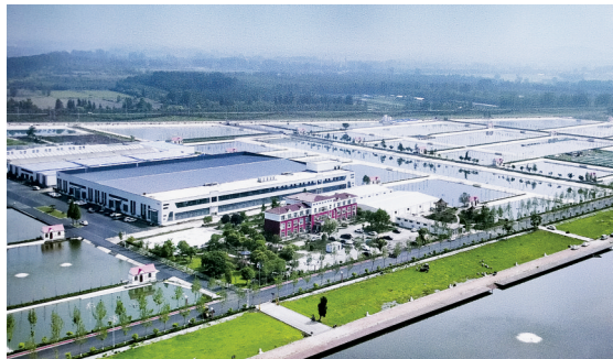
微山县微山湖现代渔业产业园升级改造项目
