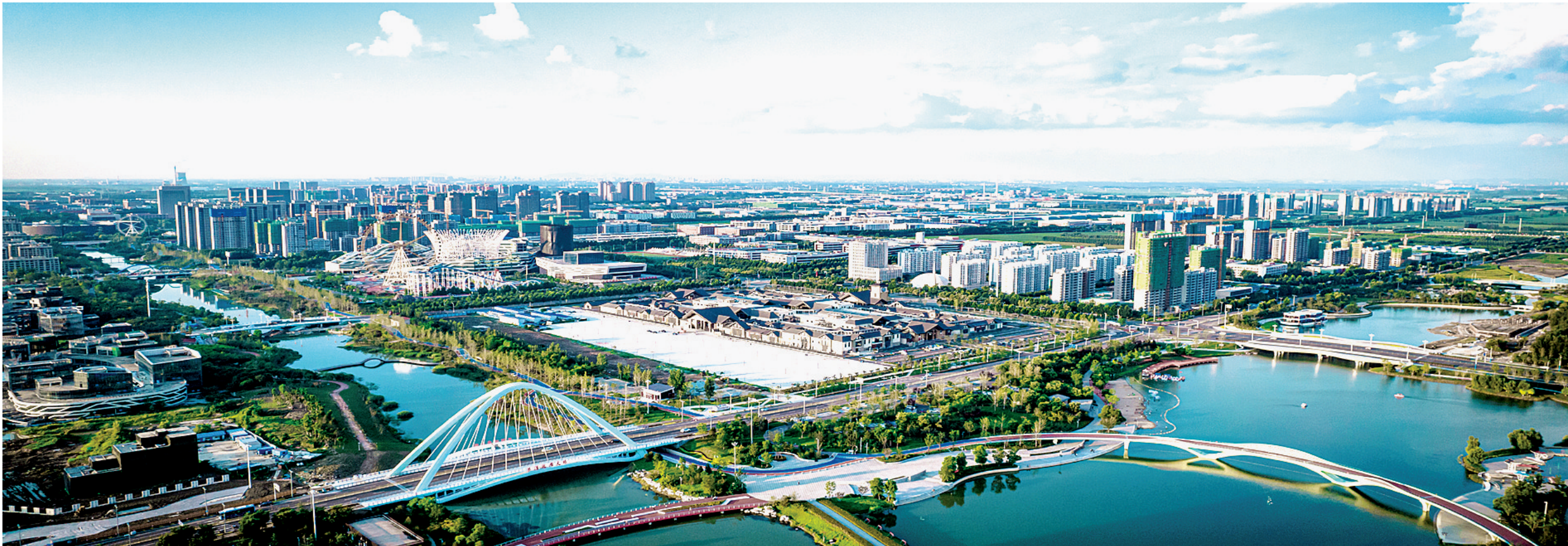
济宁高新区蓼河生态科技新城“七网”融合基础设施项目
