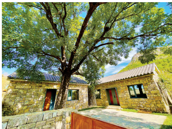
泗水县仲都乡村振兴示范片区项目
