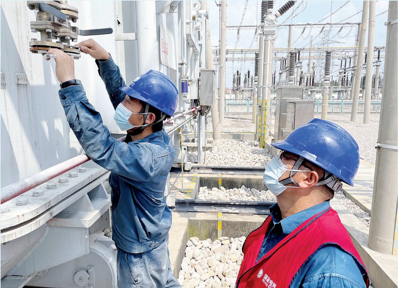
近日,国网济宁供电公司运维人员在巡视中发现220千伏凤凰变电站1号主变4号潜油泵停止工作,主变本体油位偏低。8月2日,国网济宁供电公司立即组织变电检修人员对凤凰1号变开展检修,对故障潜油泵进行更换,并在更换后充分放气,保证本体瓦斯继电器轻不动作,之后对主变本体进行补油处理,使其油位达到正常范围,保障变电设备安全可靠运行。 ■通讯员 李军 巫悦 摄
