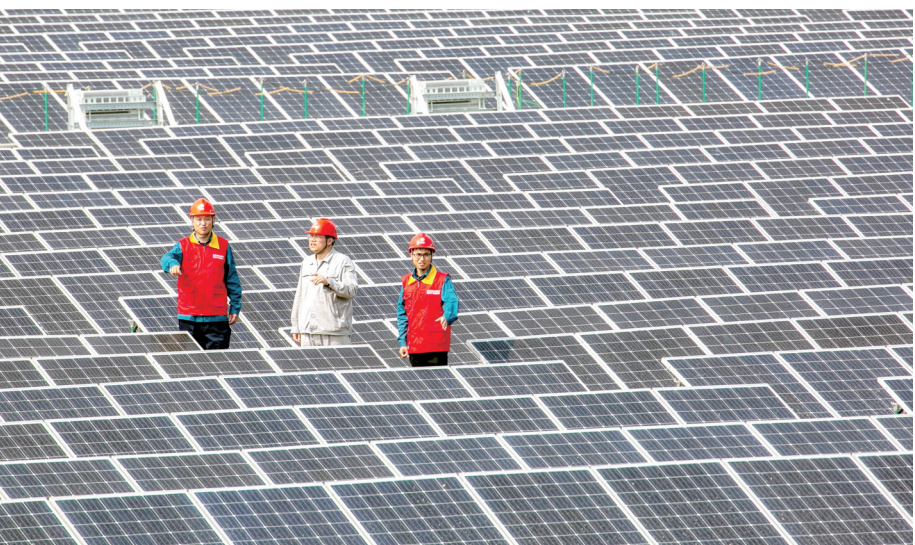
图为光伏发电项目。
