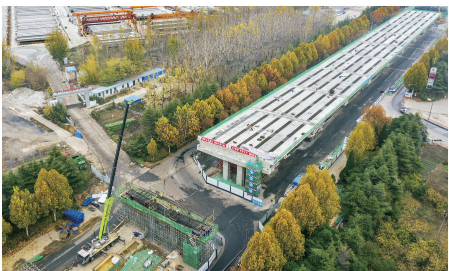
图为济曲快速路正在加紧建设。■记者 杨国庆 摄
