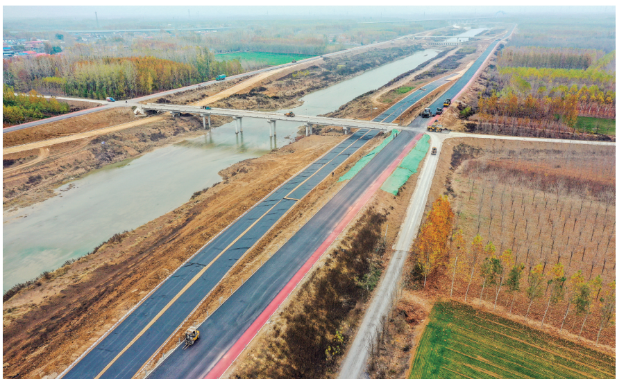
洸府河堤顶路项目正在快速推进。■记者 杨国庆 摄
