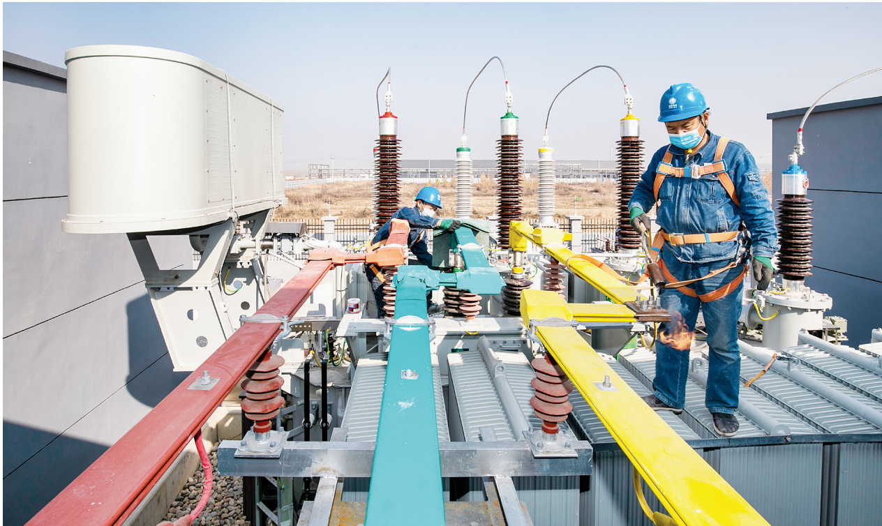
图为国网嘉祥县供电公司对供电设备和线路进行巡检维护。
