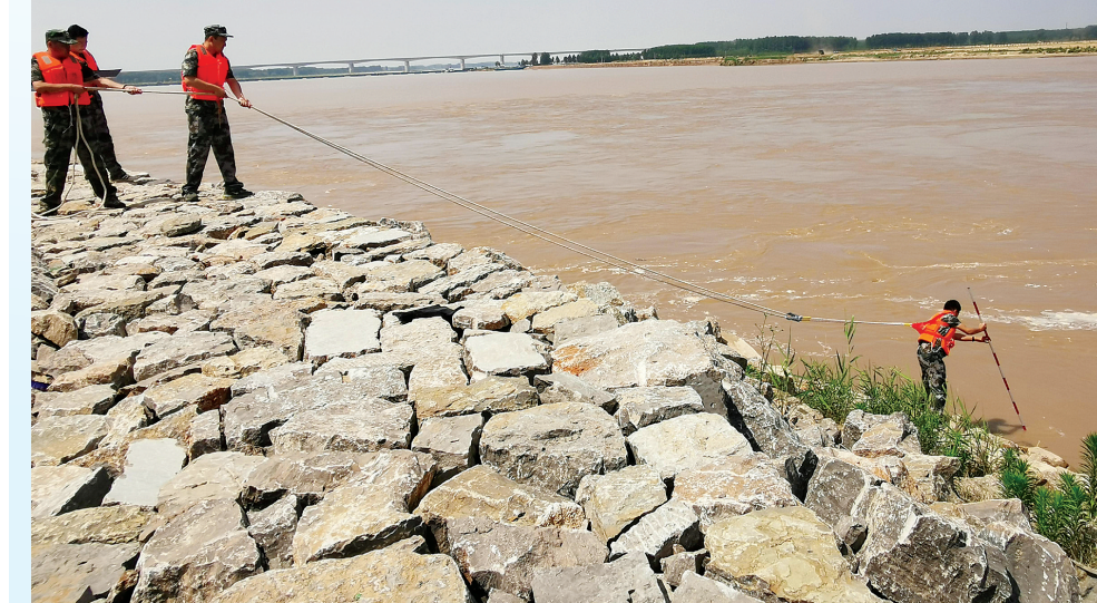
5月29日,梁山黄河水务局进行汛前水下根石探摸,探摸水下根石情况,排查安全隐患。梁山黄河水务局工作人员在汛期前进行水下根石探摸,确保汛期安全。
