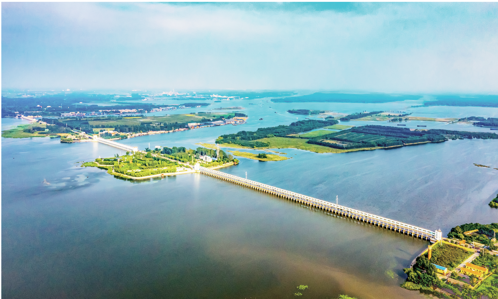
南四湖二级坝水利枢纽
