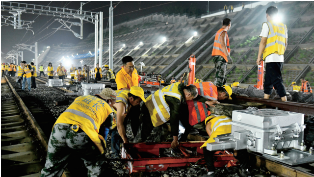
济郑高铁与济南铁路枢纽实现互联互通。8月12日,中铁十局的工作人员在济郑高铁山东段大庙屯线路所42号道岔1级施工。 ■新华社记者 郭绪雷 摄
