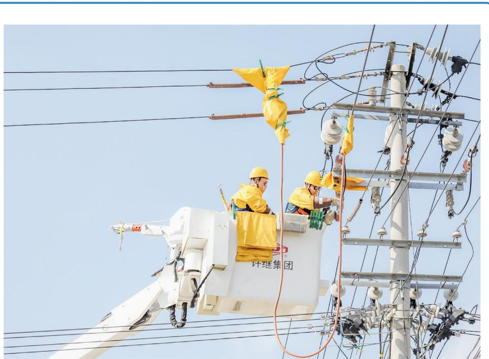
顶烈日,战酷暑,国网嘉祥县供电公司带电作业人员为10千伏中心西线卧龙山分支13#-08杆带负荷更换跌落式熔断器,及时消除线路隐患,保障广大居民用电安全可靠。 ■通讯员 王者东 摄
