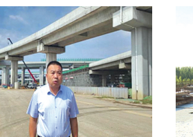
项目名称:杨柳互通立交、打通断头路
