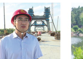
项目名称:龙拱河特大桥工程、运河新城高压管廊工程
