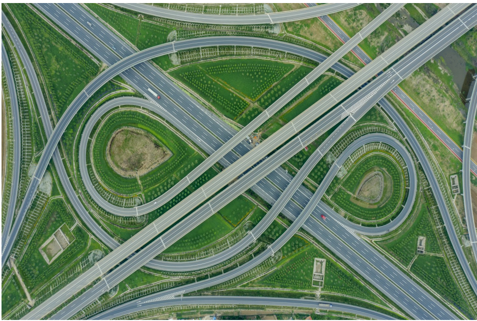
图为车辆在兖州区张家楼互通立交上来往穿梭，立体交通网有力助推济宁市建设 与经济社会高质量发展。
