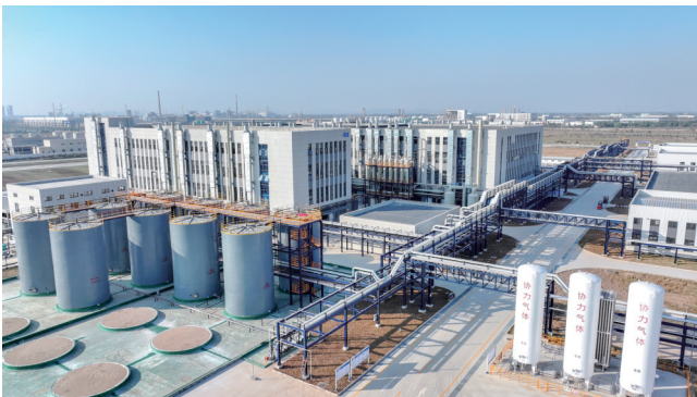
金乡县立中新能源锂电新材料项目
