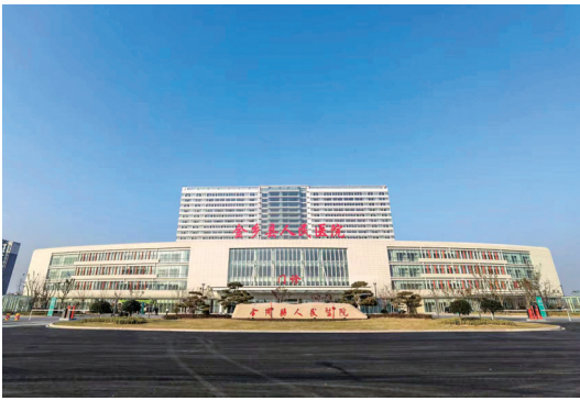
金乡县东城医院项目
