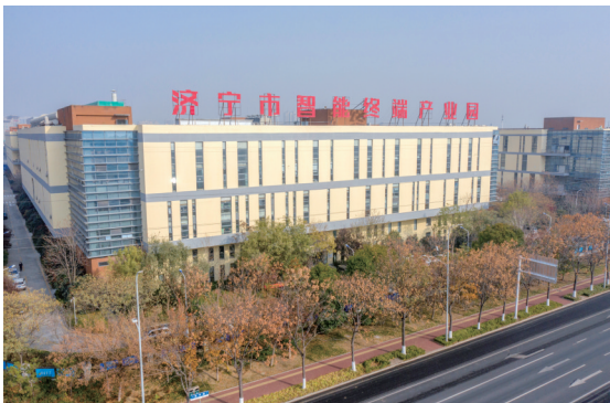
济宁高新区智能终端产业园项目
