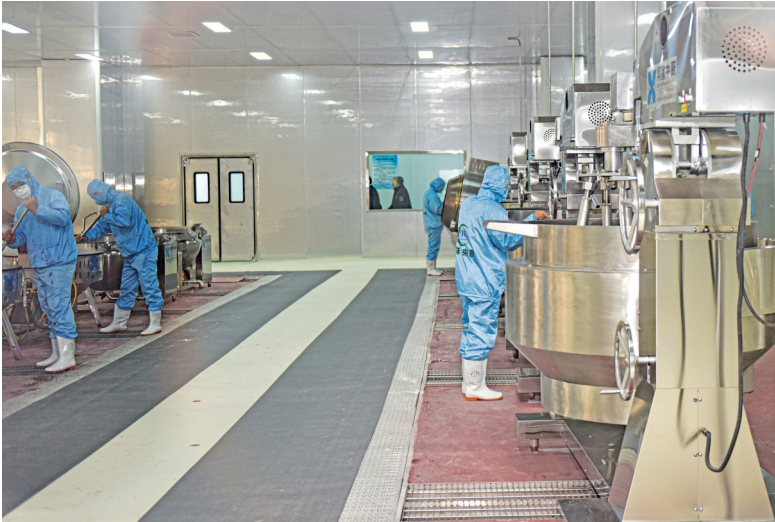
图为山东嘉味智慧冷链物流中心项目。■记者 陈硕 摄
