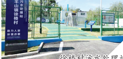
徐楼村污水处理站
