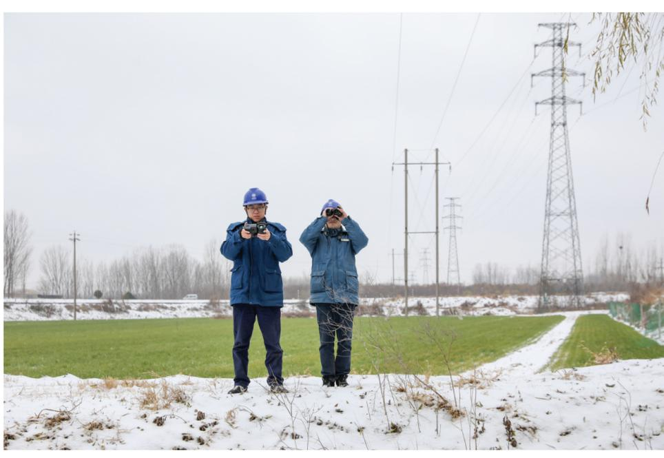
针对新一轮低温天气,国网嘉祥县供电公司运维人员对全县输电通道展开特巡,利用红外测温仪、望远镜等设备,排查线路、连接金具等安全隐患,检查线路通道受低温天气影响等情况,发现问题及时消缺,全力做好保电保供工作。
