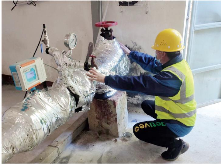
近期,我市迎来雨雪寒潮天气,济宁中山公用水务积极应对,对供水管道等设备设施加热保暖材料或安装包扎带,确保设备在低温天气下安全运行。同时,排查容易冰冻的室外表箱、管道等设施,为裸露的水表、表箱穿上防寒“棉衣”,做好保温措施。
