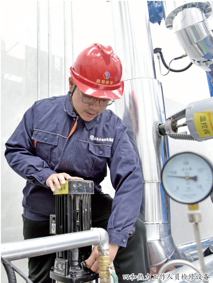
四和热力工作人员检修设备
