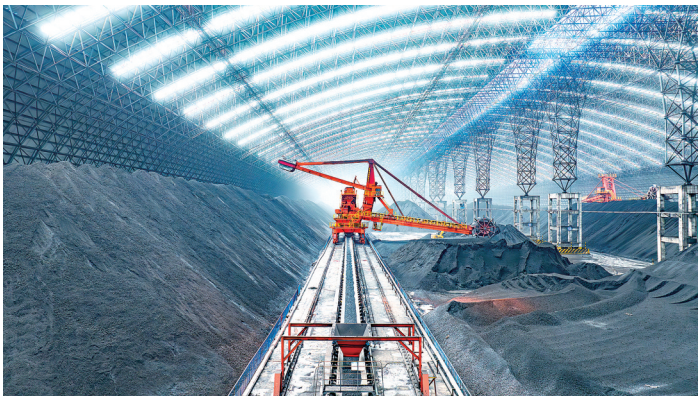
梁山港数智化光伏发电储煤棚内堆取料机正在紧张作业
