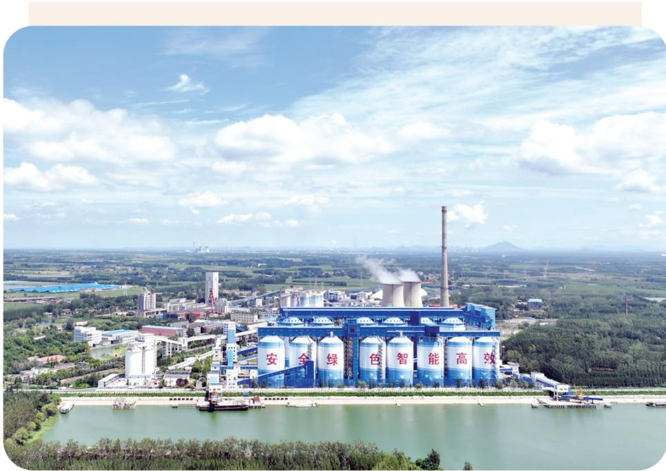
位于太白湖新区的兖矿能源集团股份有限公司济宁三号煤矿是国内第一座集煤、电、港于一体的现代化立井煤矿。为进一步做好大气污染防治工作,全面推进涉扬尘作业环节提标升级,打造扬尘治理绿色发展新标杆企业,济宁三号煤矿建设16座筒仓,配套建设密闭带式输送机栈桥、转载点,并在输送线路上设置智能化喷淋降尘系统,实现输送环节全封闭运行,在减少作业环节的同时,也从源头上遏制了煤炭扬尘污染,极大地促进了周边环境的改善。
