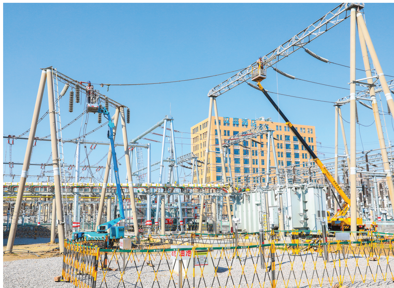
3月17日，济宁电网2025年重点技改项目220千伏高新变电站2号主变改造工程正式启动。此次改造将对已接近运行年限的2号主变进行整体更换，同步实施保护装置升级、配套设备智能化改造等工作，提升主变容量和运行效率，增强电网供电能力与抗风险能力，进一步优化区域电网结构，提升供电可靠性，为迎峰度夏负荷增长预留空间，为高新区经济社会高质量发展提供更坚实的电力保障。
