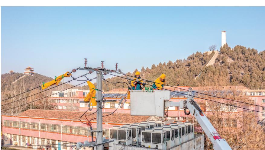
12月15日,国网嘉祥县供电公司带电作业人员在10千伏充兰Ⅱ线老年公寓支线6号杆拆除废旧临时架空线路,此举不仅为城市建设“让路”,优化市容环境,又能消除长期闲置存在的安全隐患,在保障线路安全运行的同时,为地方经济社会发展提供坚实电力支撑。
