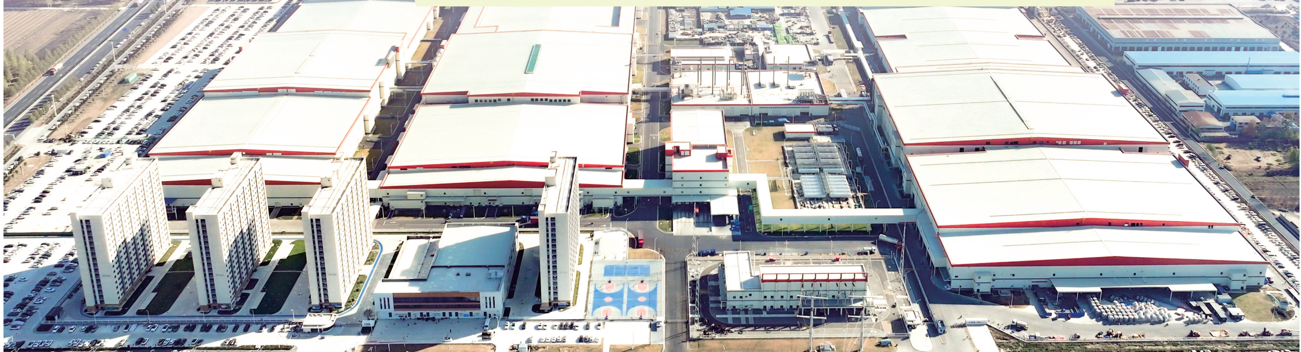
山东时代新能源电池产业基地
