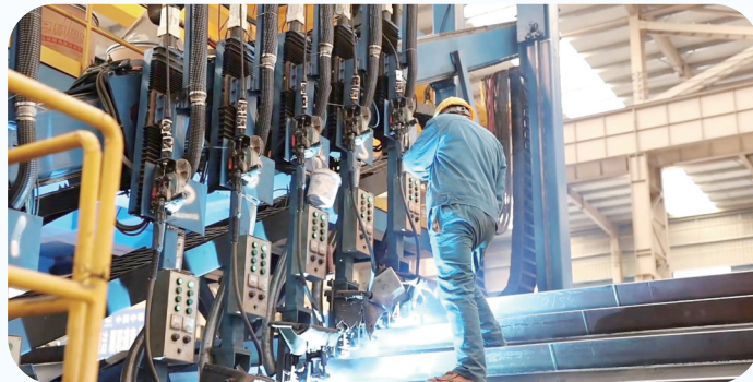
华亿5G工厂里，工人正在查看钢构件生产情况。
