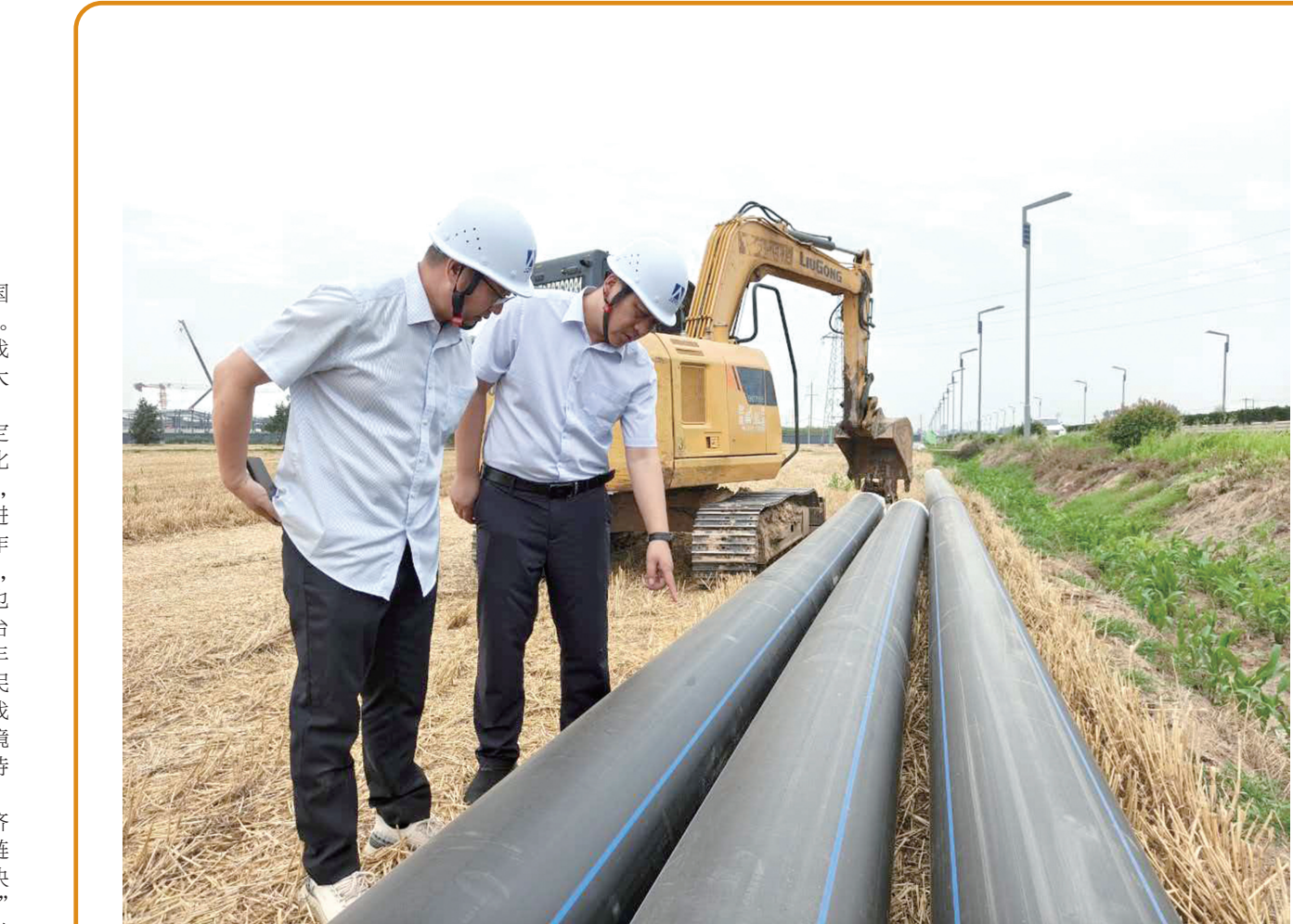
近日，由济宁中山公用水务有限公司实施建设的西满路给水管道工程全面完工并正式通水。管线总长2.1公里，采用DN400规格供水管道，实现长江水厂与济宁市现代渔业科技产业园直连供水，工程年供水能力可达200万立方米，单日供水规模稳定在8600至14700立方米，一举解决产业园核心生产用水难题，为园区发展打通关键供水“生命线”。 ■通讯员 亢凯 摄
