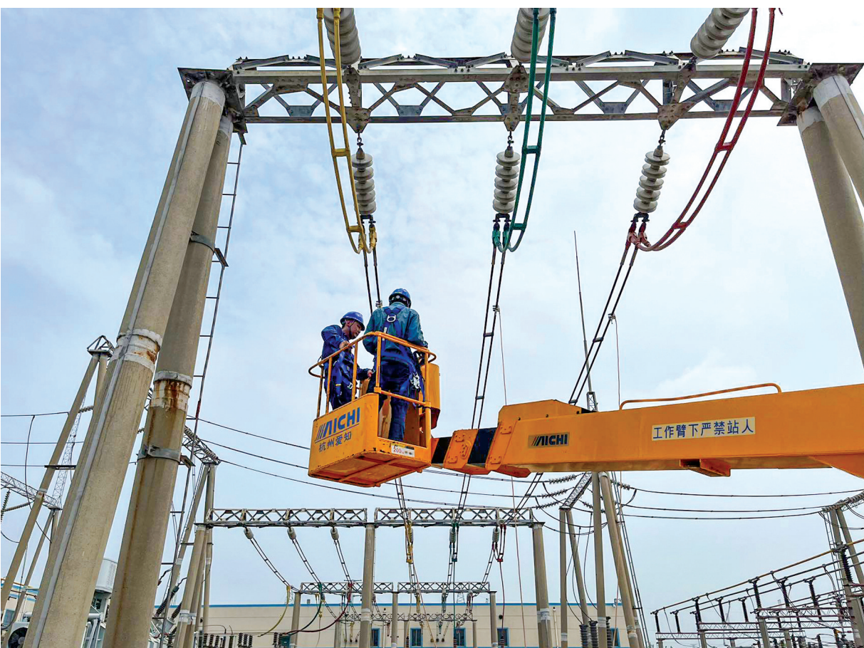
9月1日，国网济宁供电公司2023年秋检工作全面启动。为保障秋检工作安全优质高效开展，国网济宁供电公司把好标准工序执行、关键环节管控，守牢精益检修安全质量关，确保“应修必修，修必修好”，为电网迎峰度冬、春节保供奠定坚实基础。图为9月4日，变电检修人员在220千伏鱼台变电站进行2号主变35千伏侧母线桥及一次引线拆除工作。
