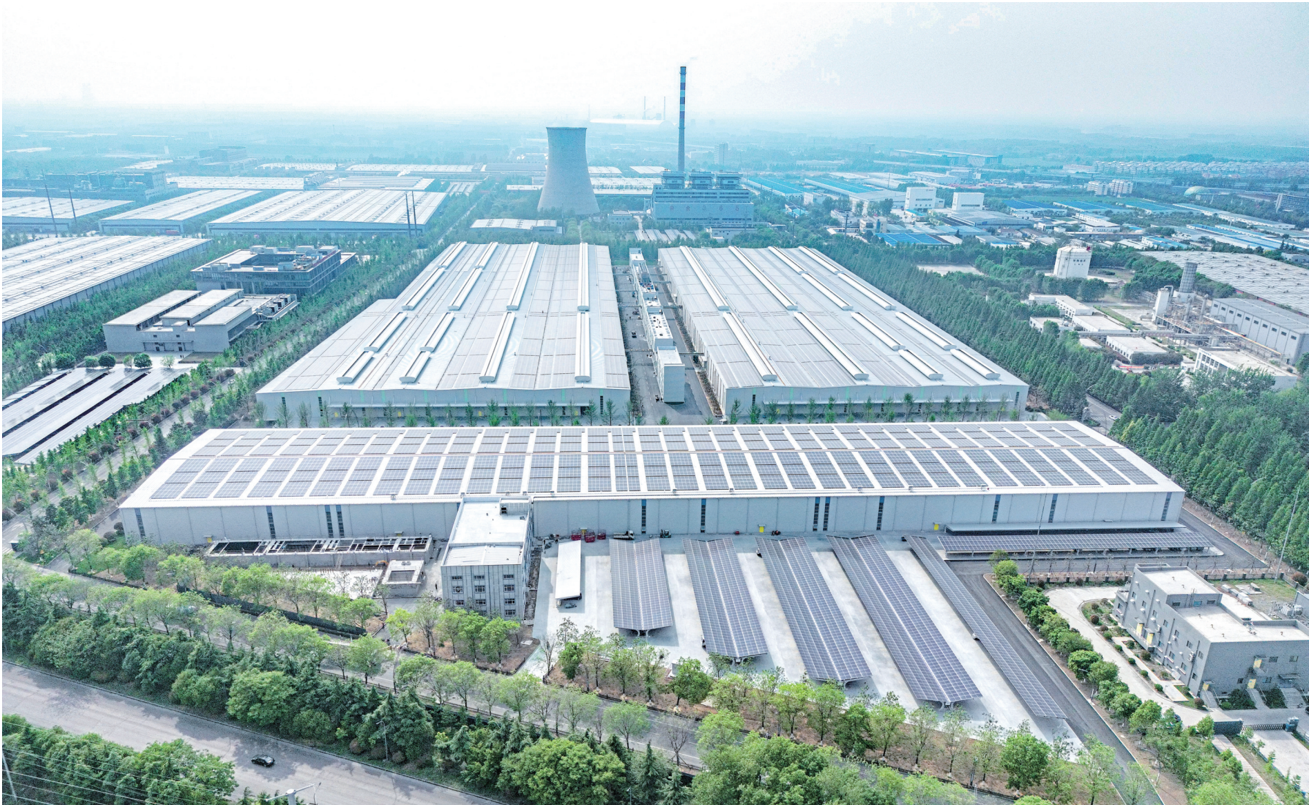
华勤高端橡胶新材料产业园一期项目
