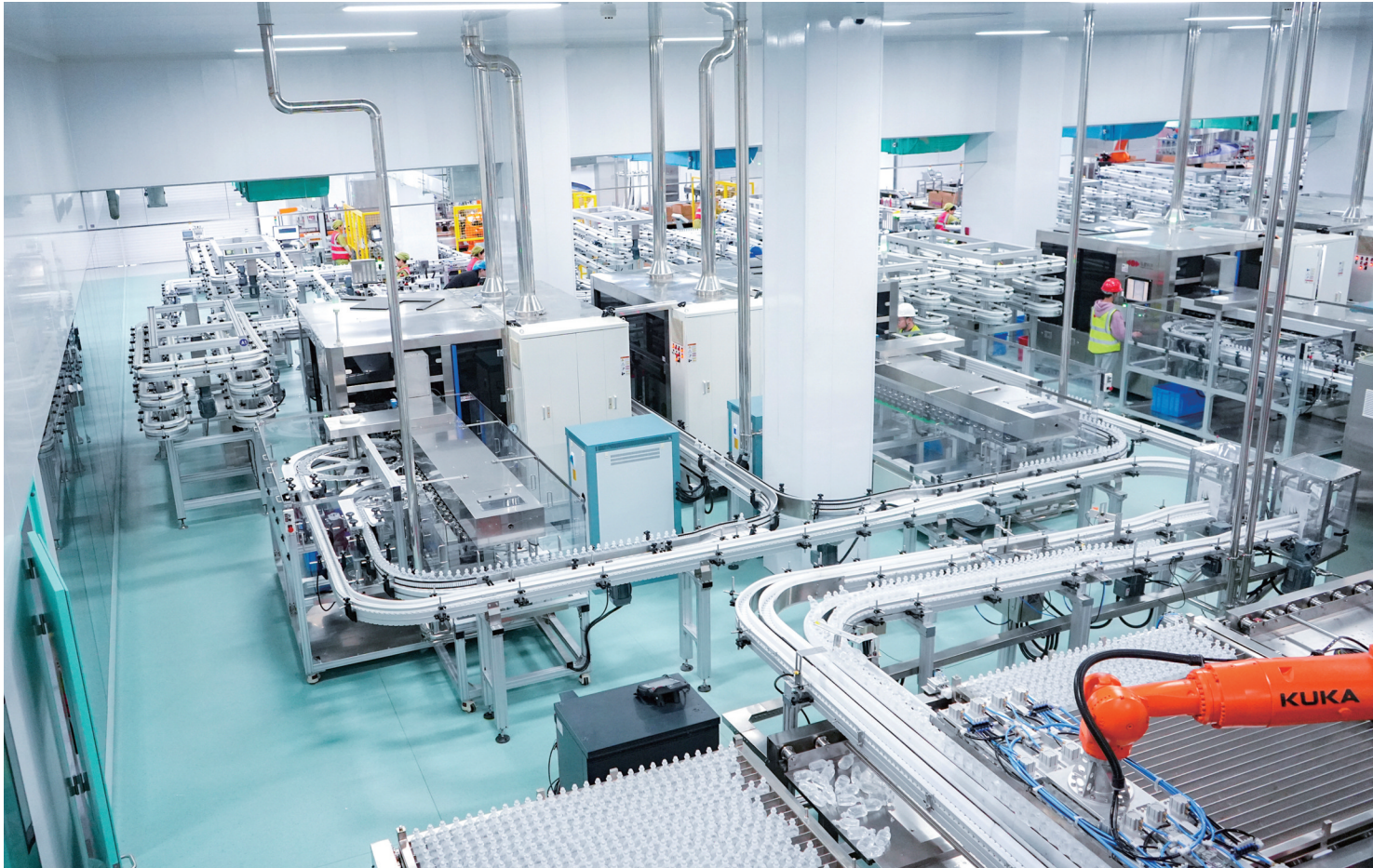
辰欣高端制剂研发及智能化集约车间项目
