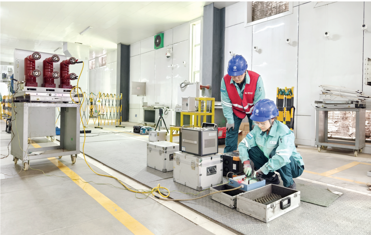
当前,济宁电网春检工作正如火如荼进行。国网济宁供电公司严把作业现场安全,精心精益检修,确保设备健康运行,为夏季高峰用电提供有力保障。图为4月22日,国网济宁供电公司变电检修人员在110千伏变电站开展开关清扫、检查、试验等工作。
