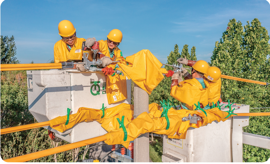
近日，国网嘉祥县供电公司带电作业人员在万张街道南田村东 10 千伏万张线 65 号杆带负荷直线杆改耐张杆作业，确保线路涉及的近千户客户正常用电不受影响，有效提升配网线路分段的灵活性，进一步提高线路安全供电可靠性。
