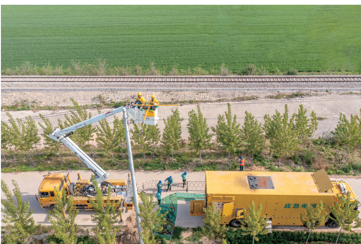
4月13日,国网嘉祥县供电公司10千伏荒东线油库分支开展绝缘化改造。施工期间为最大限度降低客户用电影响,带电作业人员在17号杆接入中压变电车,通过柔性并网方式实现后端3台变压器所带客户“零感知”用电,为区域电网安全和客户可靠用电提供坚实保障。
